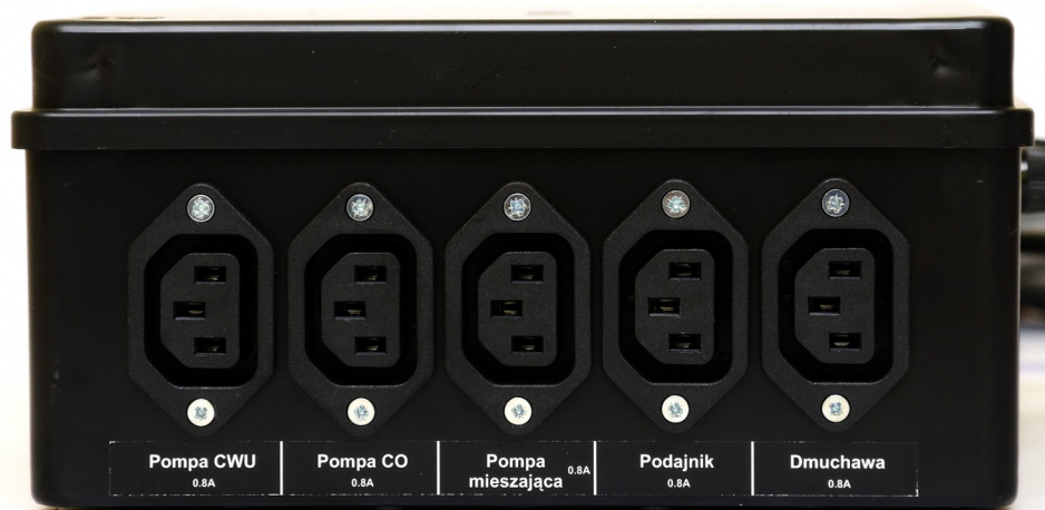
Ilustracja 5: Ścianka obudowy z wyjściami mocy
